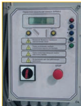
Оператор управляет режимом работы камеры с помощью микропроцессорного пульта с дисплеем.
